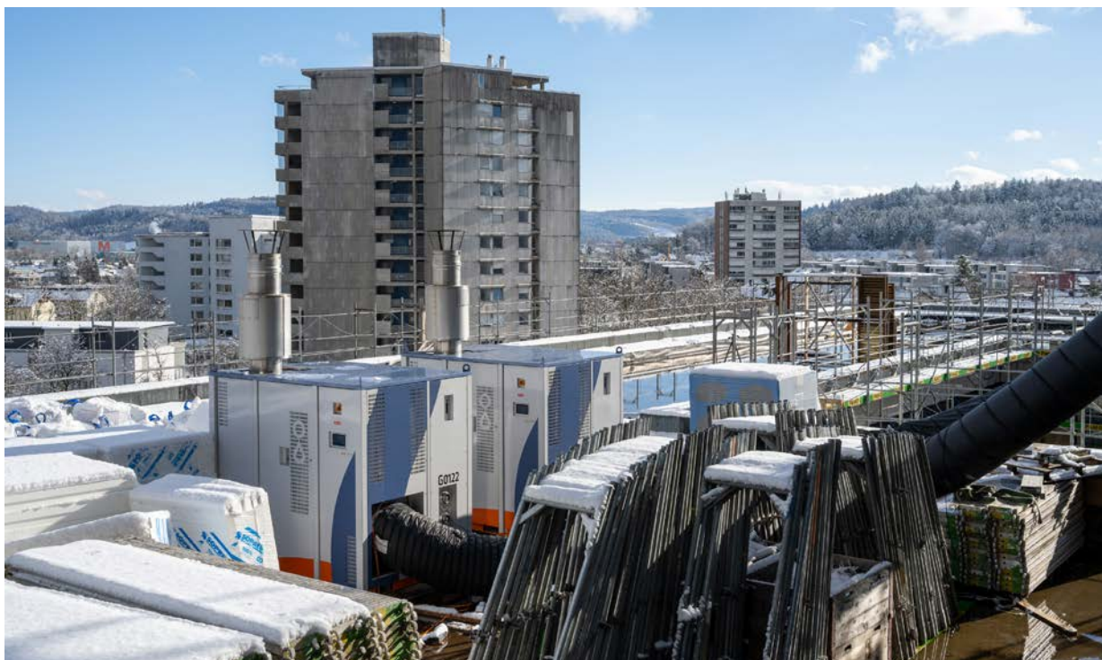
Fünf der grossen Heizmodule vom Typ G200 wurden auf dem Dach des Sockelbaus platziert.
