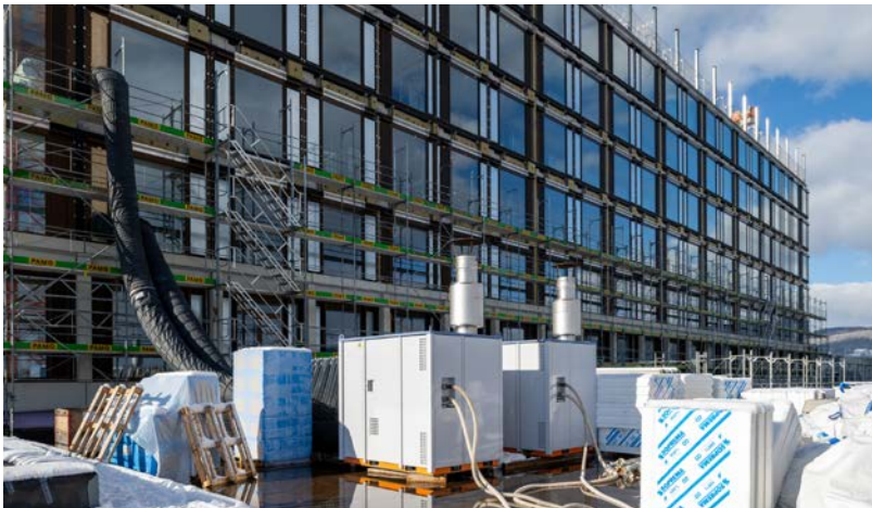
Dank der hohen Saugleistung der Module war es möglich den Brennstoff zwanzig Meter hoch aufs Dach des Sockelbaus zu fördern.
