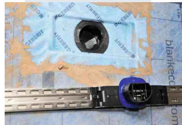
Die Duschrinne Geberit CleanLine wird auf den Einlauftrichter mit eingespritzter Abdichtmanschette (hellblau) gesetzt. Die Polyethylen-Abdichtungsbahn (blau) ist bereits verlegt. (Bild: Manuel Fischer)
