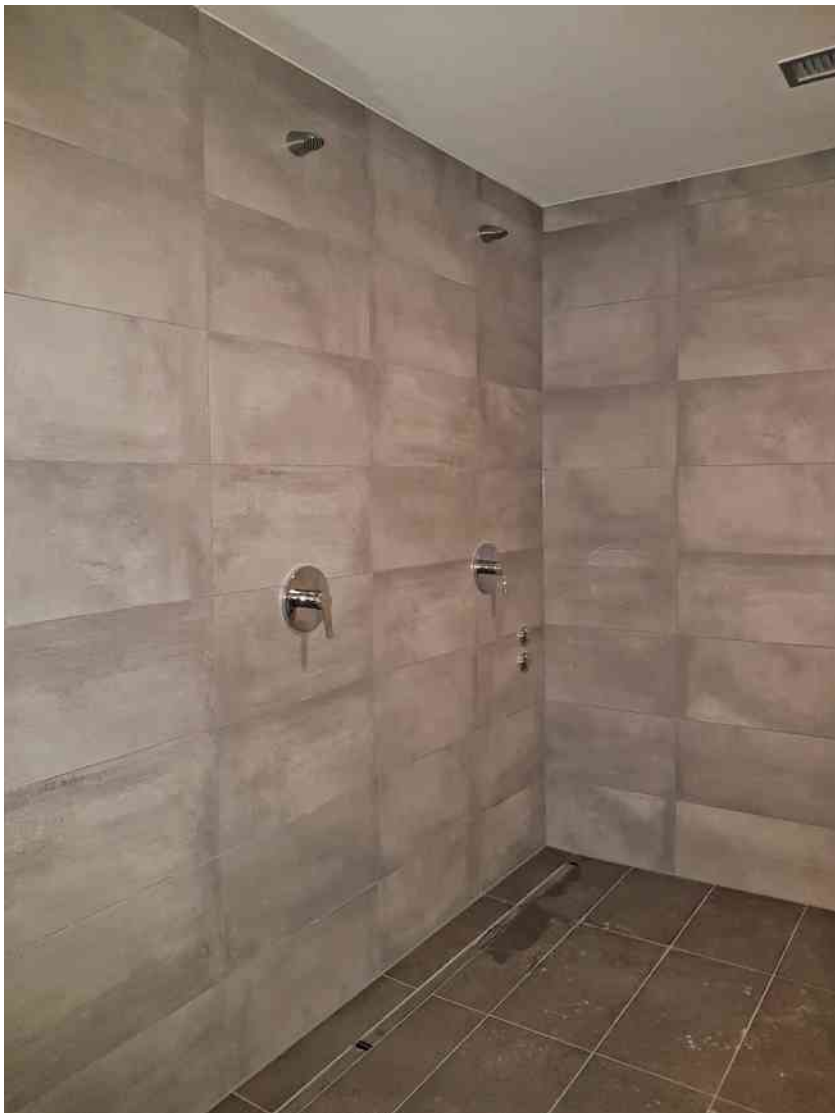
Blick in den nigelneuen Duschrom.
