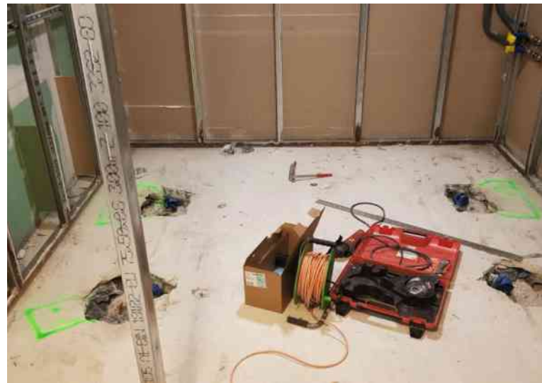
Die alten Bodenabläufe wurden aus dem Betonboden herausgespitzt. (Bild: Würkli Haustechnik AG)
