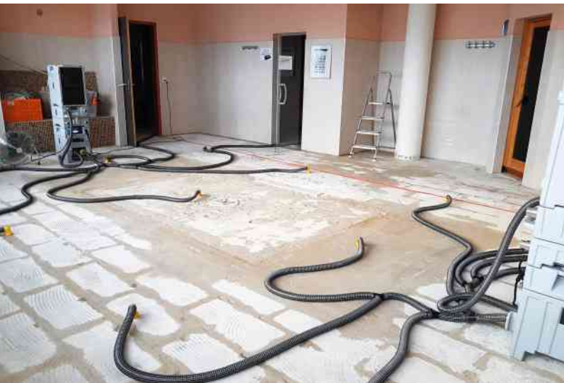
Prozessluft wird über Bodenöffnungen (Kernbohrungen) eingeflutet und andernorts Feuchtluft über einen Verdichter abgesaugt.
