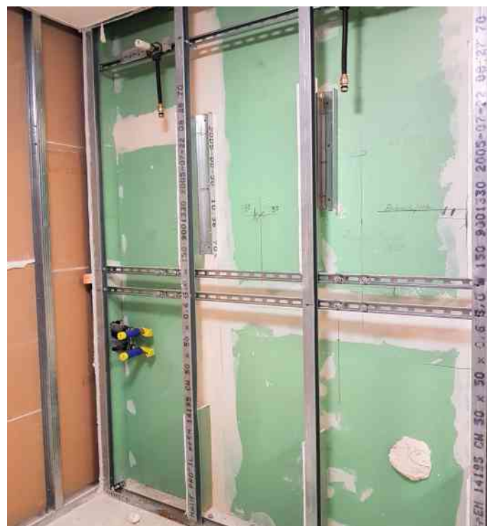
Blick auf die sanierte Vorwandinstallation mit Montageelementen und neu Absperrhähnen (links) zur Not-Unterbrechung der Wasserzufuhr.
