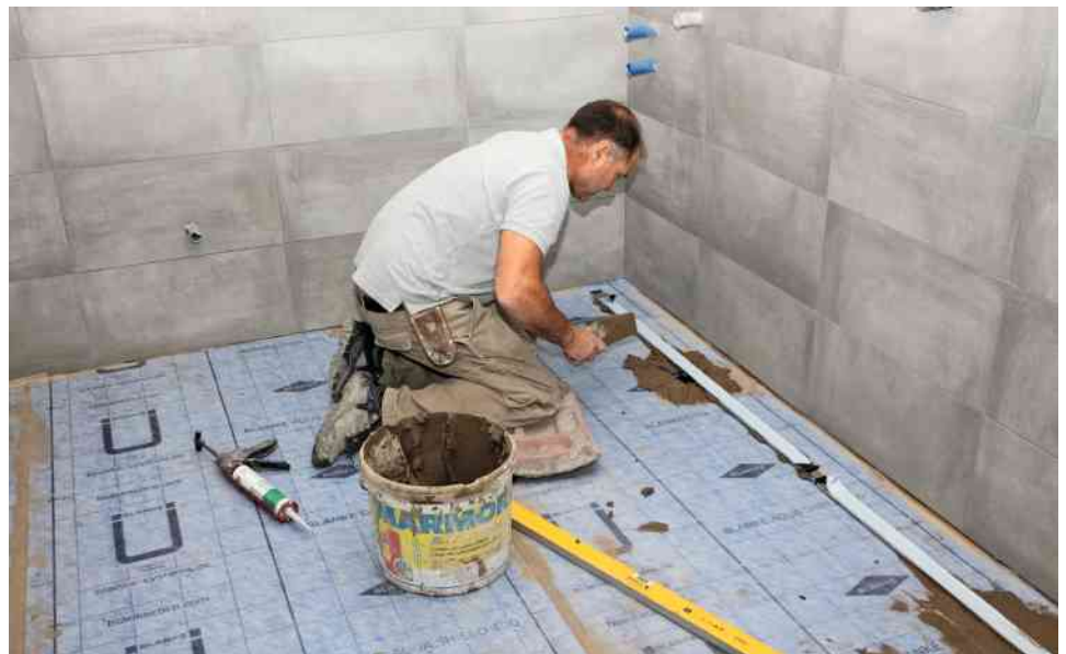
Der Plattenleger verlegt die festen und wasserdichten Abdichtungsbahnen aus Polyethylen. Die Bahn ist mit einem Vliesgewebe zur wirksamen Verankerung des Fliesenklebers versehen. (Bild: Manuel Fischer)
