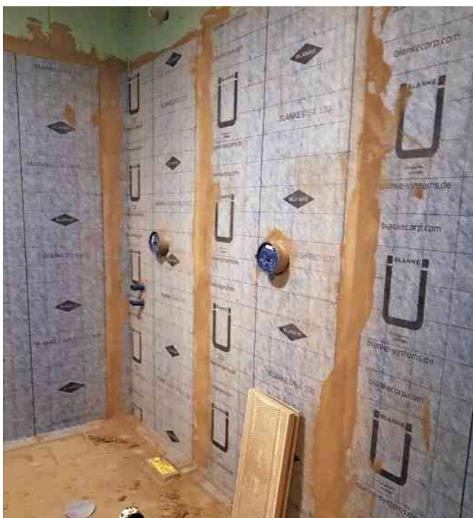
Die neu errichteten Gipswände werden ebenfalls mit der wasserdichten riss-überbrückenden Abdichtungsbahn eingekleidet.
